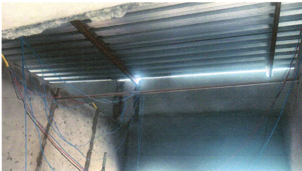
Foto 19 - TRAMA DE AÇO COMPOSTA POR TERÇAS PARA TELHADOS DE ATÉ 2 ÁGUAS PARA TELHA ONDULADA DE FIBROCIMENTO, METÁLICA, PLÁSTICA OU TERMOACÚSTICA, INCLUSO TRANSPORTE VERTICAL. AF_07/2019
