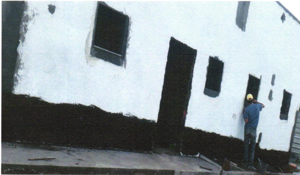
Foto 33 - IMPERMEABILIZAÇÃO DE SUPERFÍCIE COM MANTA ASFÁLTICA, UMA CAMADA, INCLUSIVE APLICAÇÃO DE PRIMER ASFÁLTICO, E=3MM. AF_06/2018
