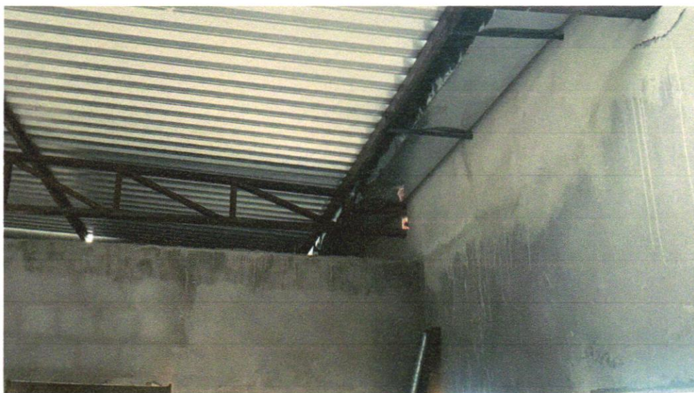
Foto - 32 - CALHA EM CHAPA DE AÇO GALVANIZADO NÚMERO 24, DESENVOLVIMENTO DE 100 CM INCLUSO TRANSPORTE VERTICAL. AF_07/2019
