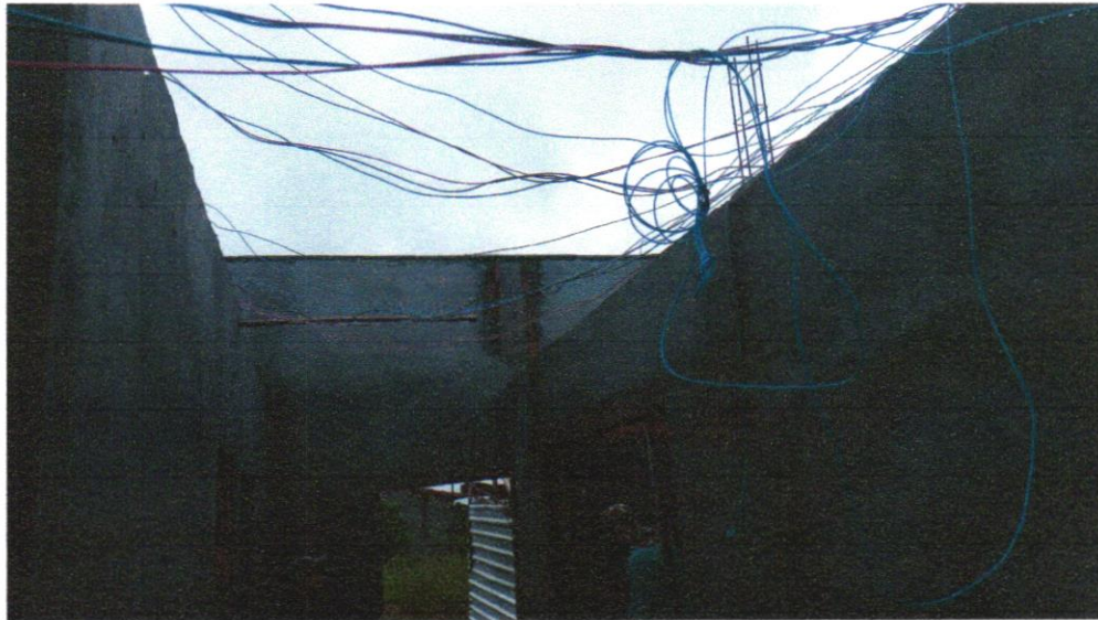
Foto 21 - CABO DE COBRE FLEXÍVEL ISOLADO, 4 MM 2 , ANTI-CHAMA 450/750 V, PARA CIRCUITOS TERMINAIS - FORNECIMENTO E INSTALAÇÃO. AF_12/2015
