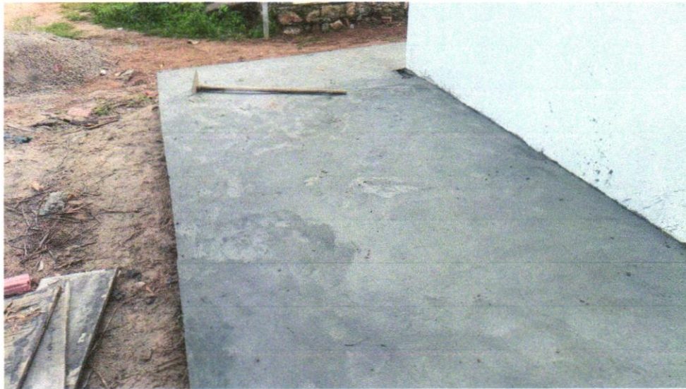
FOTO 03 - EXECUÇÃO DE PASSEIO (CALÇADA) OU PISO DE CONCRETO COM CONCRETO MOLDADO IN LOCO, USINADO, ACABAMENTO CONVENCIONAL, NÃO ARMADO. AF_07/2016
