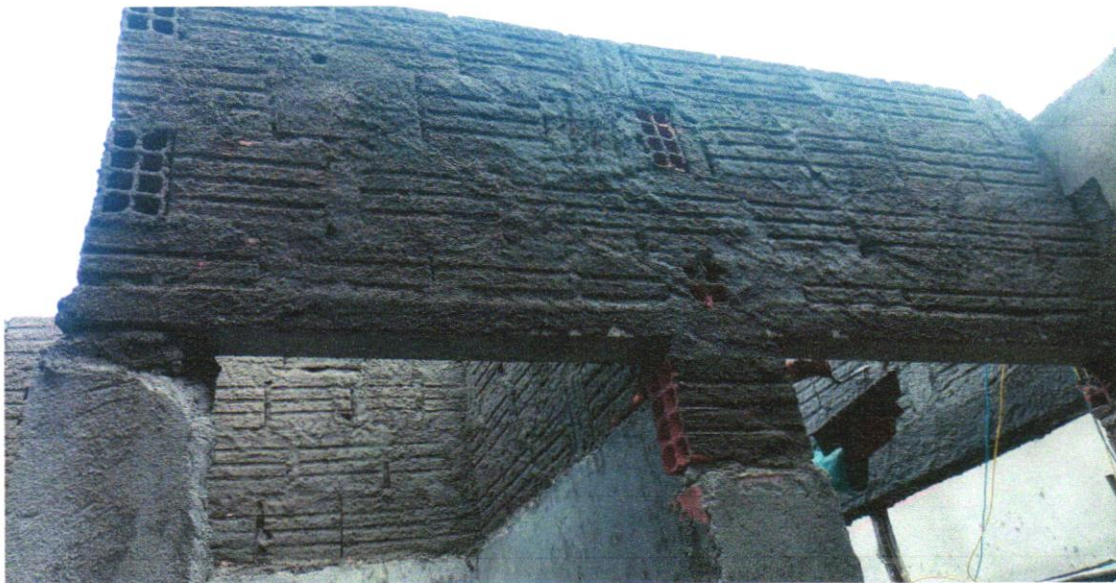
Foto 10 - CHAPISCO APLICADO EM ALVENARIAS E ESTRUTURAS DE CONCRETO INTERNAS, COM COLHER DE PEDREIRO. ARGAMASSA TRAÇO 1:3 COM PREPARO EM BETONEIRA 400L. AF_06/2014
