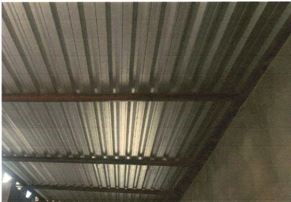
Foto 31 - TRAMA DE AÇO COMPOSTA POR TERÇAS PARA TELHADOS DE ATÉ 2 ÁGUAS PARA TELHA ONDULADA DE FIBROCIMENTO, METÁLICA, PLÁSTICA OU TERMOACÚSTICA, INCLUSO TRANSPORTE VERTICAL. AF_07/2019
