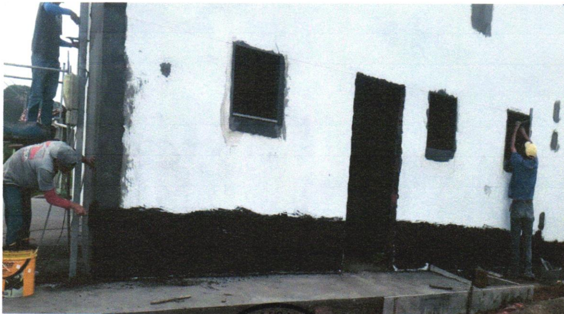
Foto - 34 - IMPERMEABILIZAÇÃO DE SUPERFÍCIE COM MANTA ASFÁLTICA, UMA CAMADA, INCLUSIVE APLICAÇÃO DE PRIMER ASFÁLTICO, E=3MM. AF_06/2018
