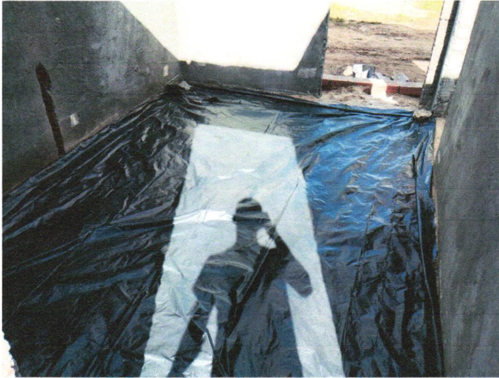
Foto 29 - APLICAÇÃO DE LONA PLÁSTICA PARA EXECUÇÃO DE PAVIMENTOS DE CONCRETO. AF_04/2022
