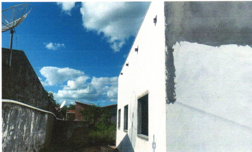
Foto 14 - APLICAÇÃO E LIXAMENTO DE MASSA LÁTEX EM PAREDES, UMA DEMÃO. AF_06/2014
